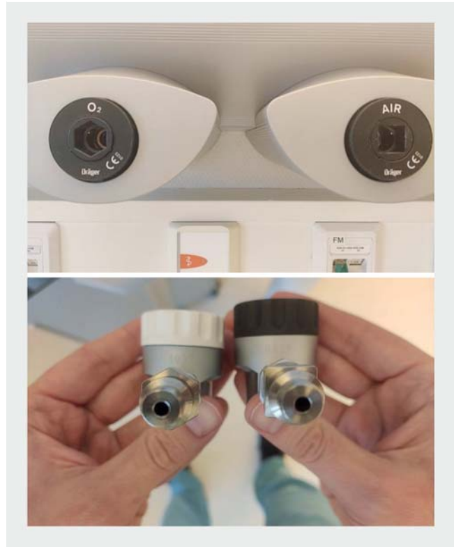
► Abb. 3 Anschlüsse und Steckverbindungen für Sauerstoff (sechseckig) und Druckluft (viereckig). https://www.awmf.org/leitlinien/detail/II/020-021.html [rerif]
