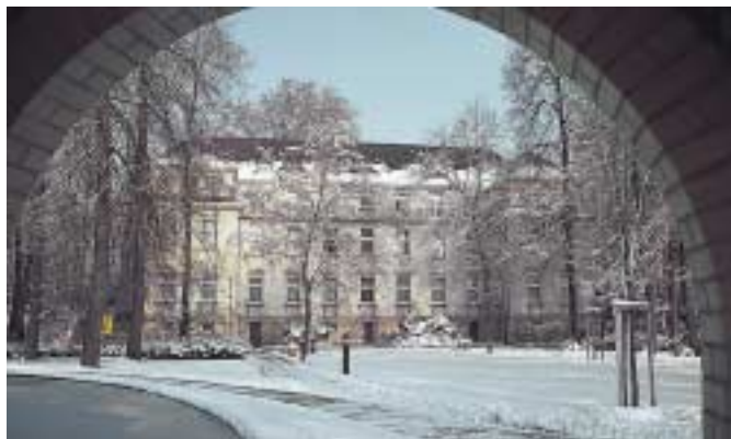
Abb. 6 Ansicht der Hautklinik Mannheim 1985, gesehen aus dem winterlichen Park.
