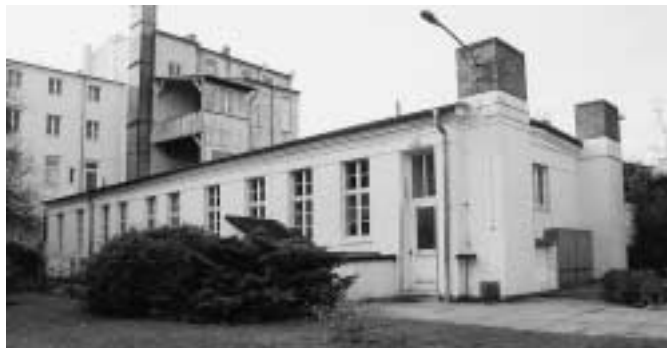
Abb. 6 Fotografische Aufnahme des aktuellen Zustandes; im Hintergrund das ursprüngliche Wohnhaus aus dem 19. Jahrhundert.
