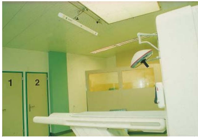
Abb.1 Raum für die registrierungsfreie Navigation auf Basis von CT-Bilddaten. Rechts im Bild die Gantry des CT und der ange-koppelte CT-Tisch. Über dem CT-Tisch an der Decke fix montiert befindet sich die Infrarot-kamera.
